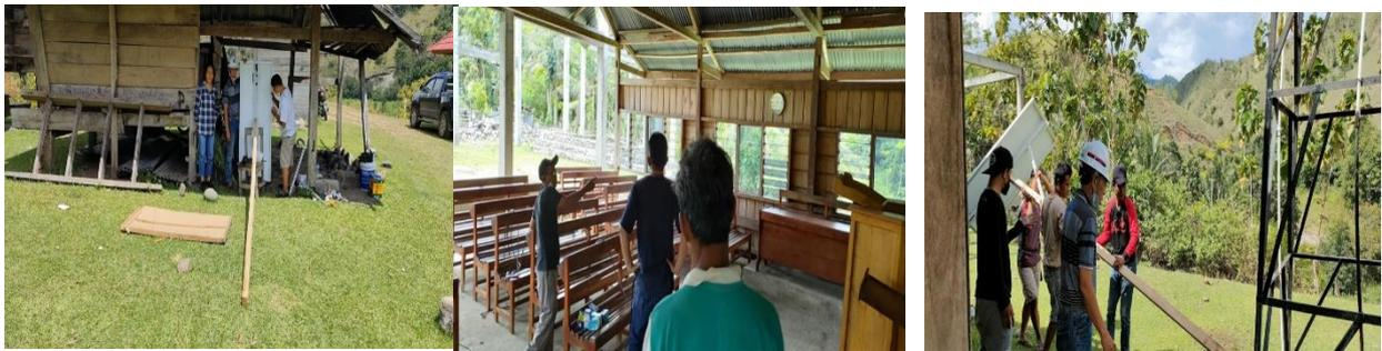
**Gambar 4.** Pemasangan Panel pada tiang penyangga, Pemasangan Instalasi Listrik, Pendirian Tiang Penyangga dan Panel Surya
